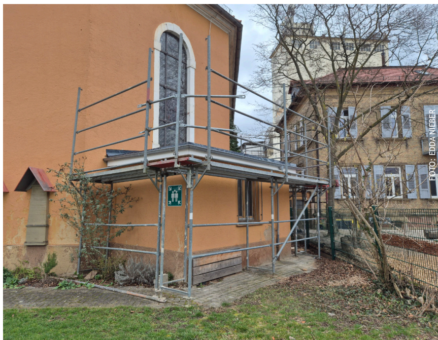
Dass richtig viel an der Sakristei gearbeitet wurde, sieht man auch von außen.
