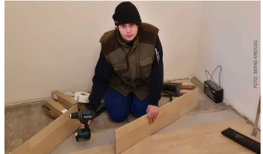
Jonas Bühler bei der Arbeit: Zunächst muss das alte, beschädigte Laminat entfernt werden.
