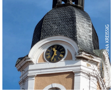
Der Kirchturm ist mit schwarzgrauem Schiefer verkleidet, der vor 390 Millionen Jahren entstand.
